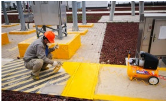
2018 年 7 月 12 日，龙源内蒙古公司兴和风电场检修人员按照安全文明标准化要求，进行涂刷黄黑相间的警示标示漆。
