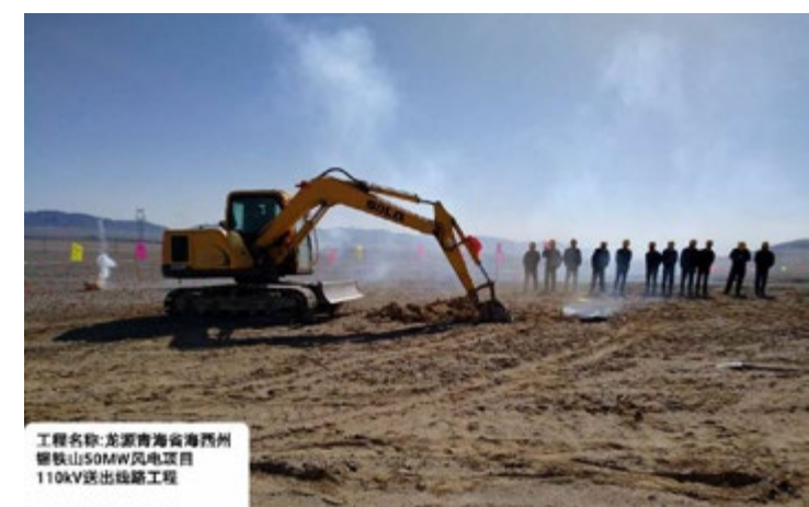
龙源青海公司海西州锡铁山50MW风电项目110KV送出线路工程开工仪式
