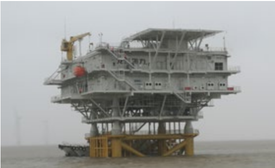
蒋家沙海上升压站
