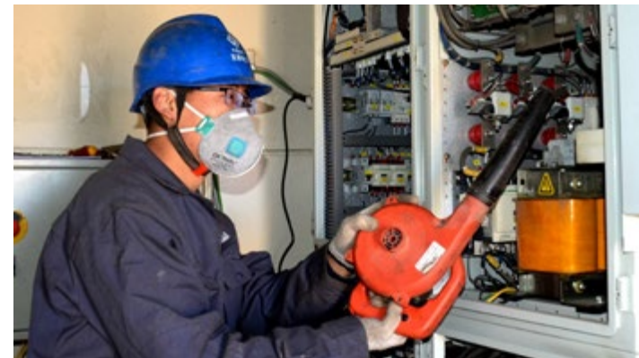
为进一步加强风电机组运行状态管理，及时发现并消除隐患缺陷，确保风电机组安全稳定运行，2018 年 3 月 22 日，龙源河北公司东湾风电场巡检人员在清洁维护风机变频器。
